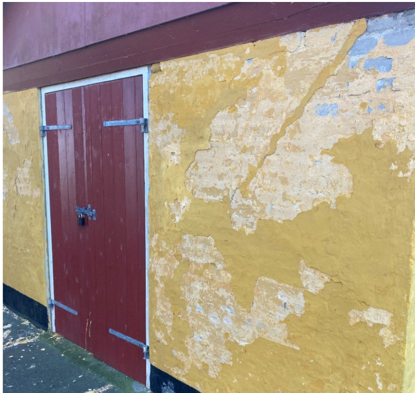
Og murværket ind til værkstedet.
